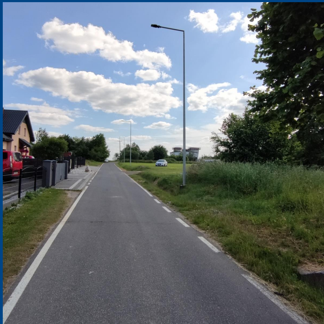
oświetlenie przy ul. Ekologicznej w Krzyżowicach
