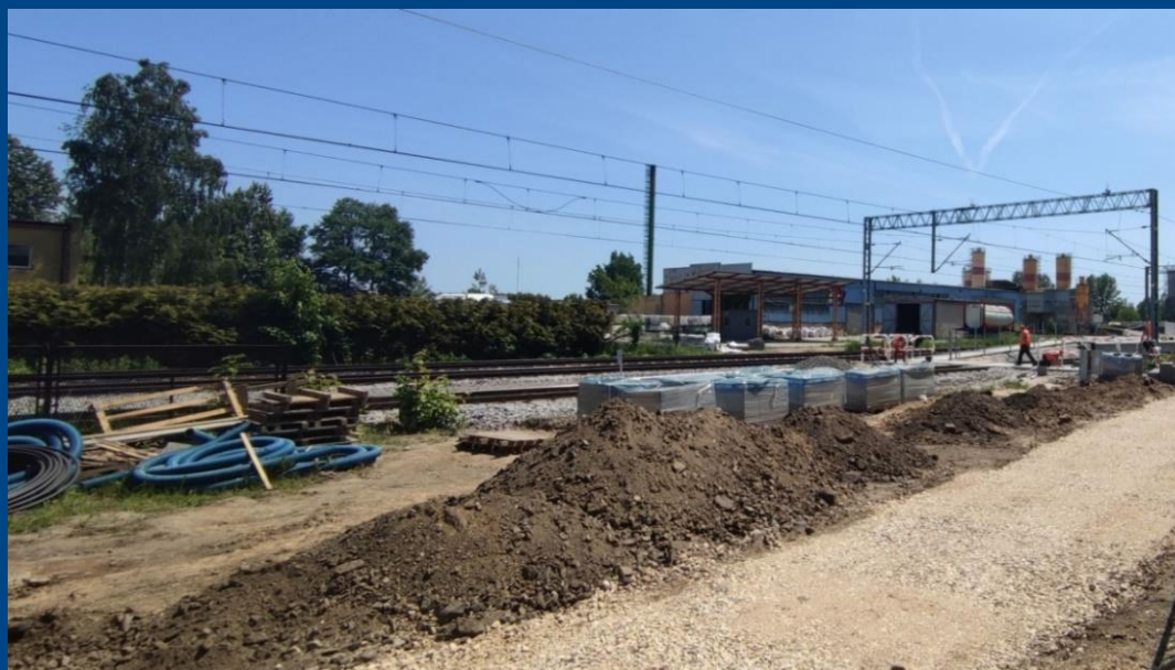
Budowa peronu w Warszowicach
