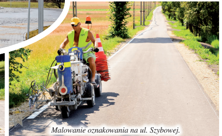
Malowanie oznakowania na ul. Szybowej.
