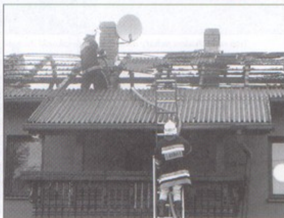
Dach domu spłonął niemal doszczętnie.
