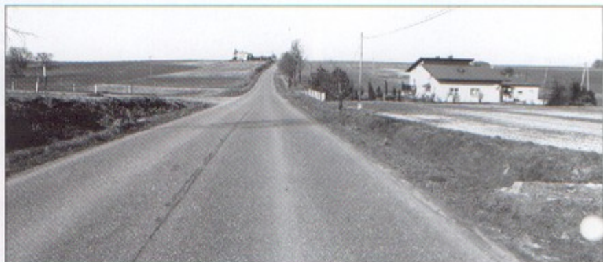
Ulica Śląska w Krzyżowicach już latem zostanie oświetlona.
