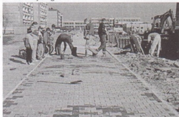
A tu już na piaseczku kładą płytki.
