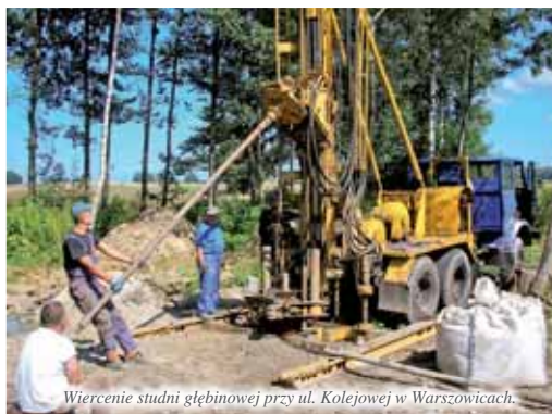
Wiercenie studni głębinowej przy ul. Kolejowej w Warszowicach.
