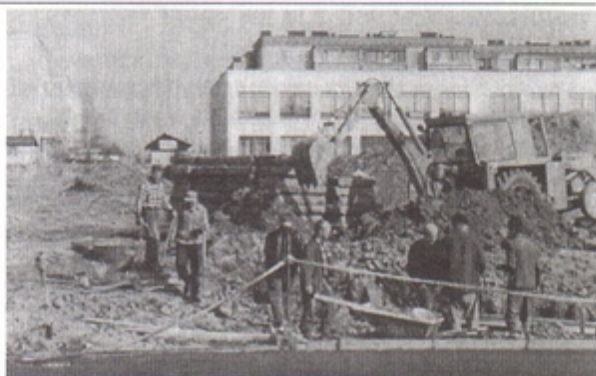
Szybko postępuje droga od Górniczej wokół Zespołu Szkół w Pawłowicach-Osiedlu.
