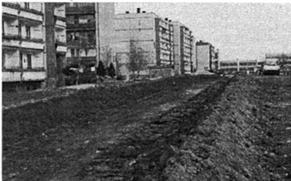
Torowanie szlaku pod trakt na dotychczasowych pustakiach.
