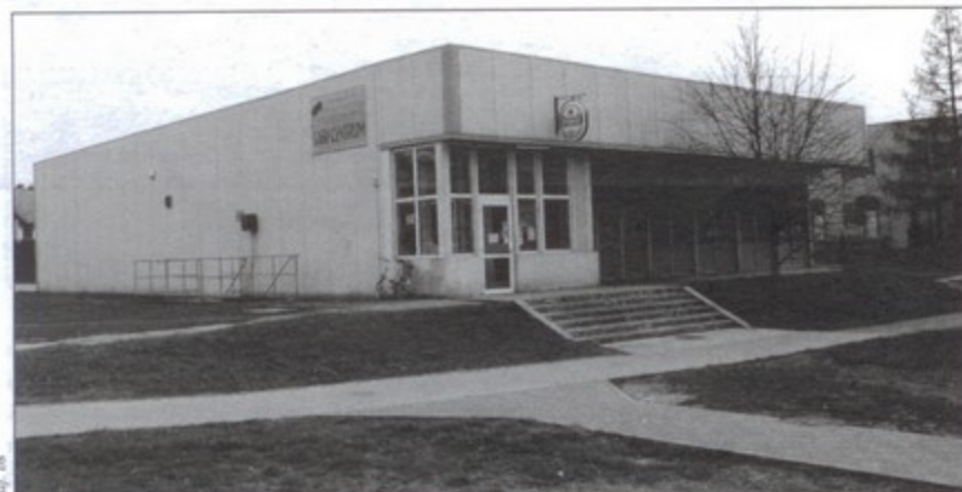
W pawilonie GABI-CENTRUM będzie się znajdować nowa siedziba spółdzielni.
