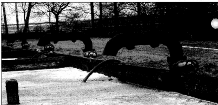
Po modernizacji poletka osadowe będą stanowiły tylko dodatkowe zabezpieczenie na wypadek awarii.
