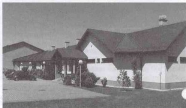
Pierwszą inwestycją gminy po zmianach w 1990 r. była budowa szkoły w Pielgrzymowicach.
