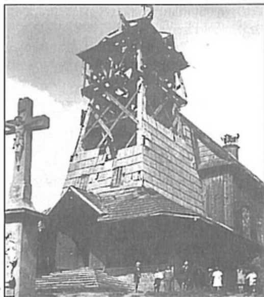
Zniszczenia wojenne z 1945 roku.
