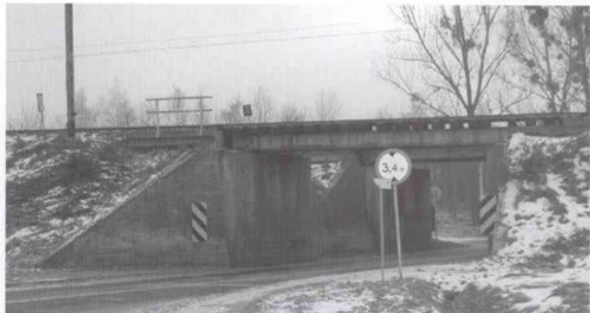
W rejonie wiaduktu kolejowego przy dworcu w Pawłowicach zostanie wybudowany wjazd z obwodnicy na dwupasmówkę.
