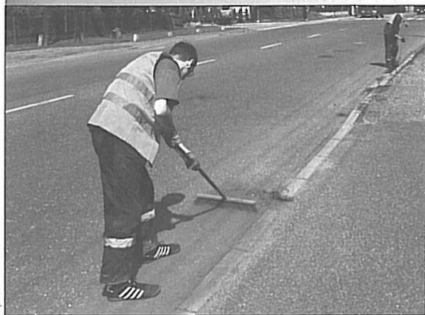
Bezrobotni wykonują prace porządkowe oraz drobne remonty.
