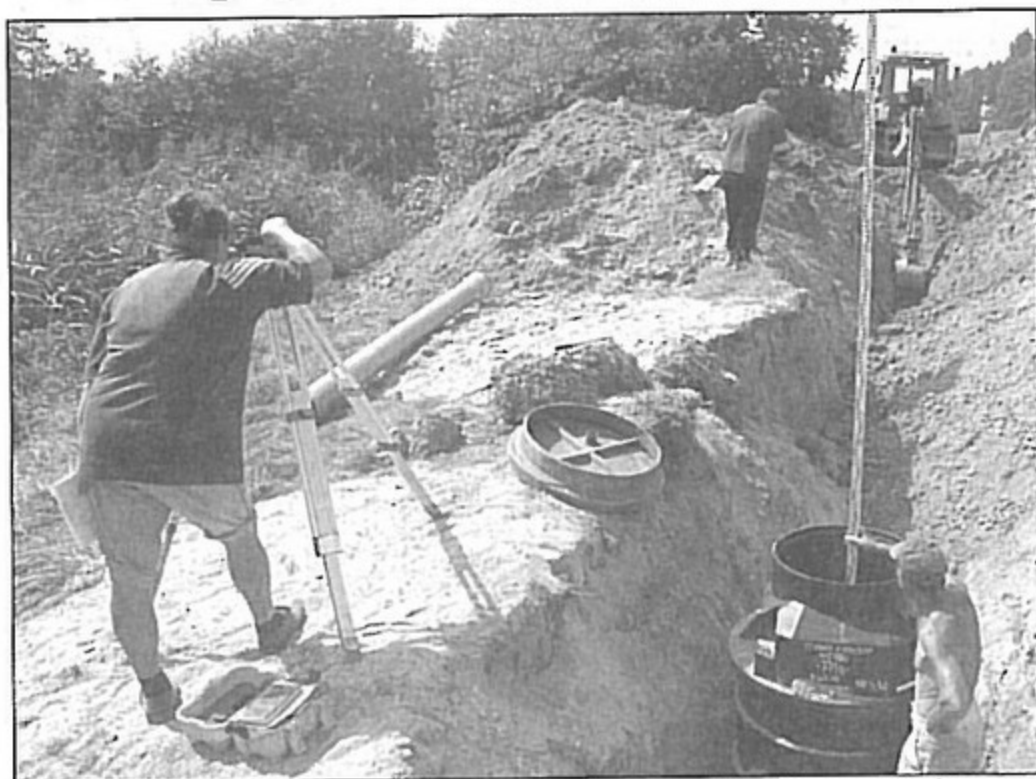
Po raz pierwszy w naszej gminie przy budowie kanalizacji pracuje kobieta.
