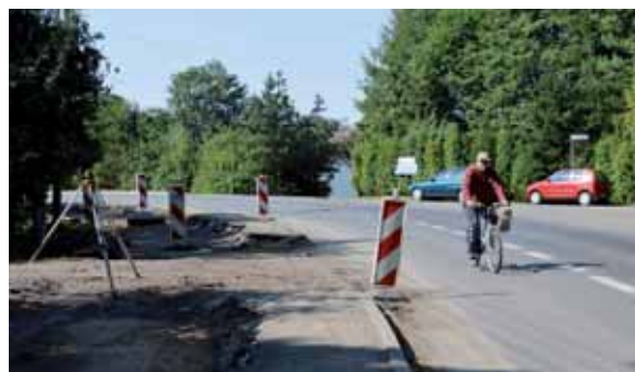
Przy ulicy Zjednoczenia powstaje ścieżka pieszo-rowerowa.
