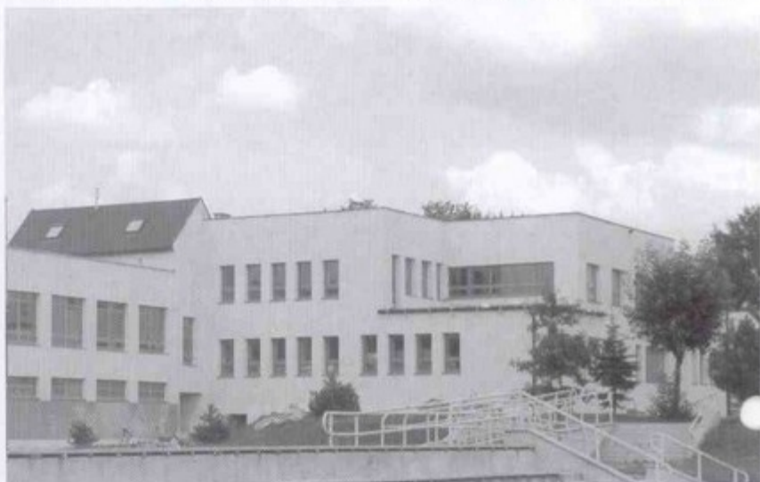
Budynek Zespołu Szkół Ogólnokształcących w Pawłowicach przeszedł gruntowną modernizację.
