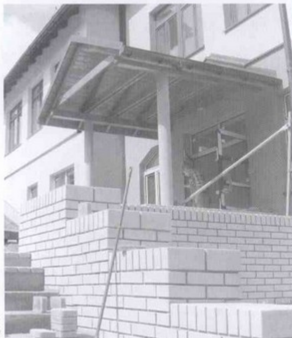
Budowa nowego wejścia do szkoły w Pielgrzymowicach jest już na finiszu.
