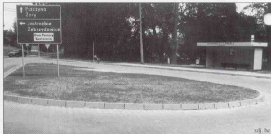
Zakończono prace przy pętli autobusowej w Golasowicach
