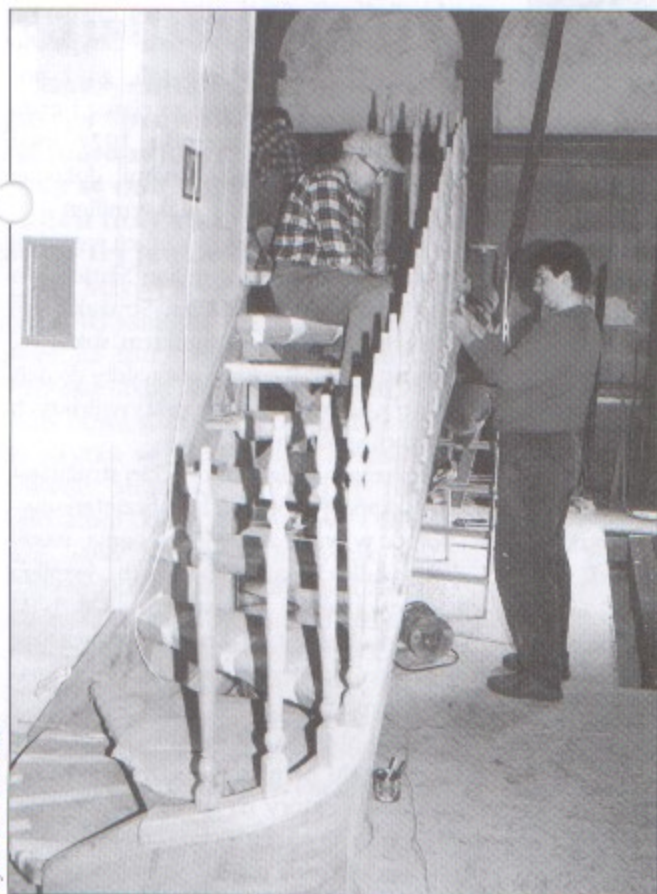
Pan Józef Staniek (w okularach) w czasie budowy drewnianych schodów samonośnych.
