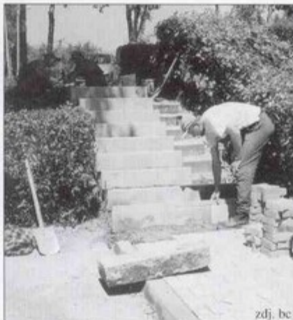
Przy okazji budowy parkingu w miejsce starych schodów wybudowano nowe.
