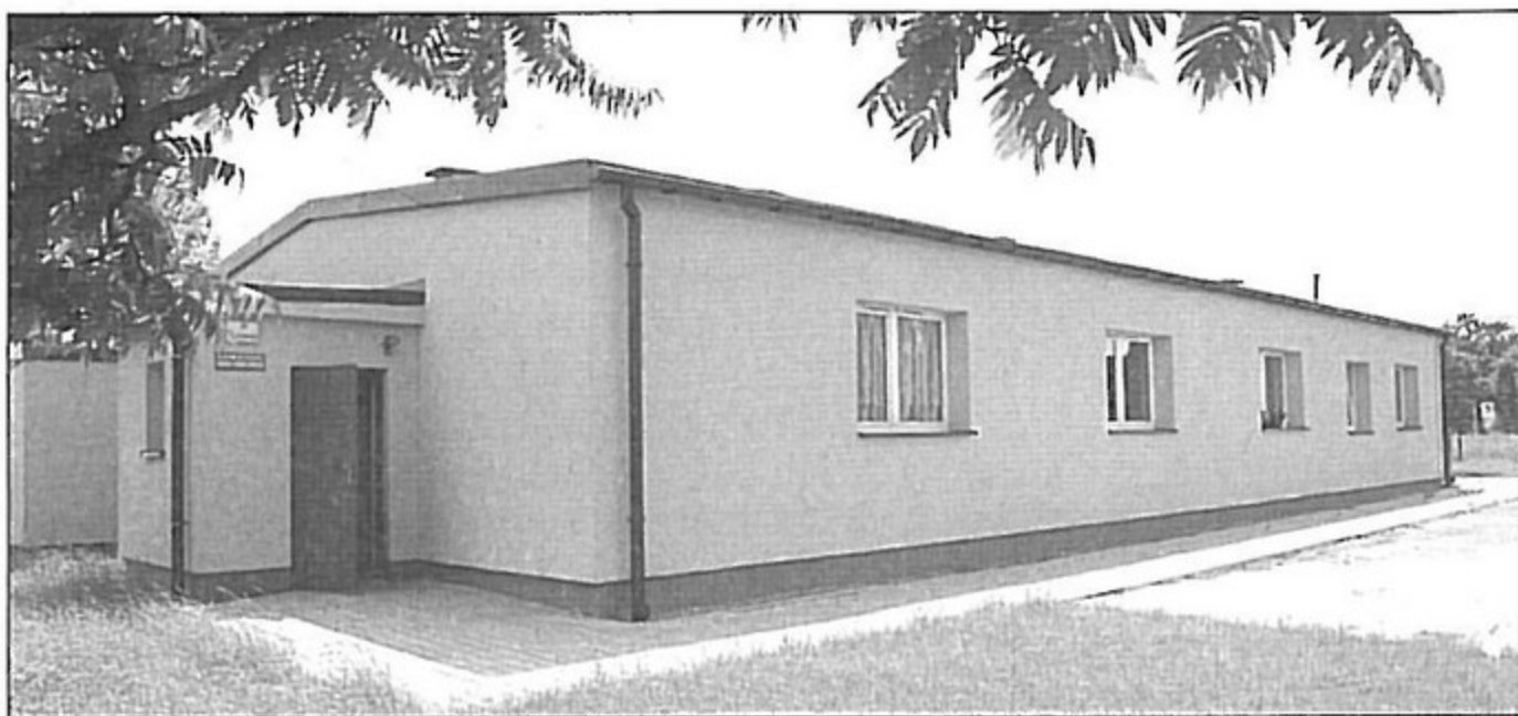
Oddany w zeszłym roku budynek socjalny w Jarząbkowicach.
