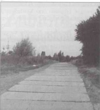
Betonowe płyty na Polnej zostaną zlikwidowane.
