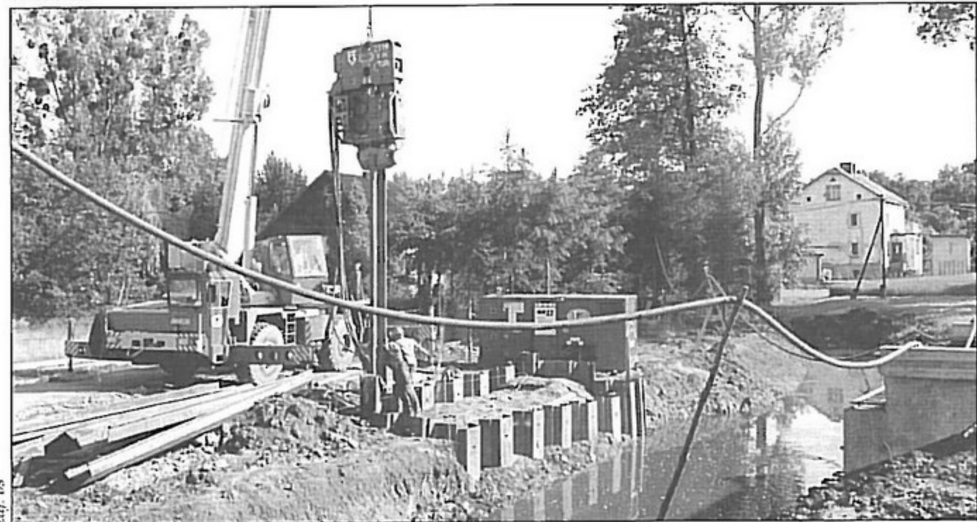
Prace przy budowie drugiego przyczółka.
