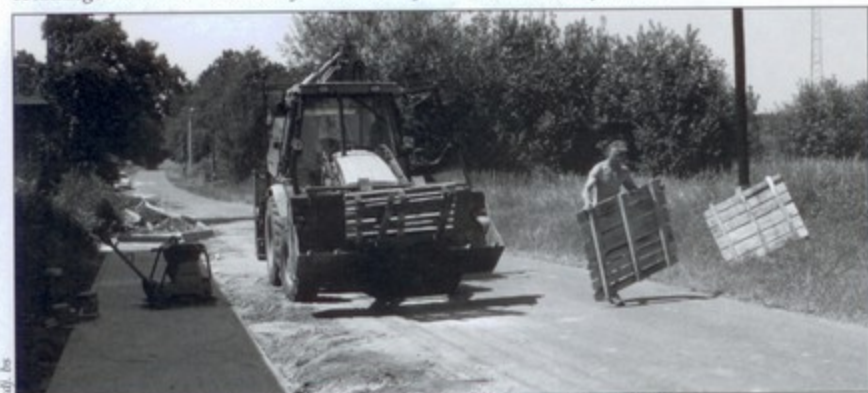
Trwa budowa chodnika przy ulicy Kruczej w Pniówku.
