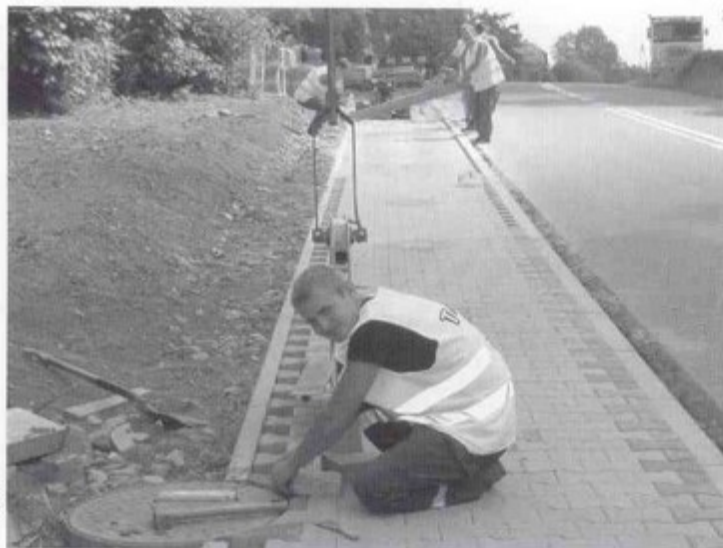
Trwa budowa chodnika przy ul. Boryńskiej w Warszowicach.
