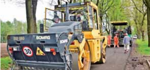
Na finiszu są prace związane z remontem ul. Klonowej w Pawłowicach.
