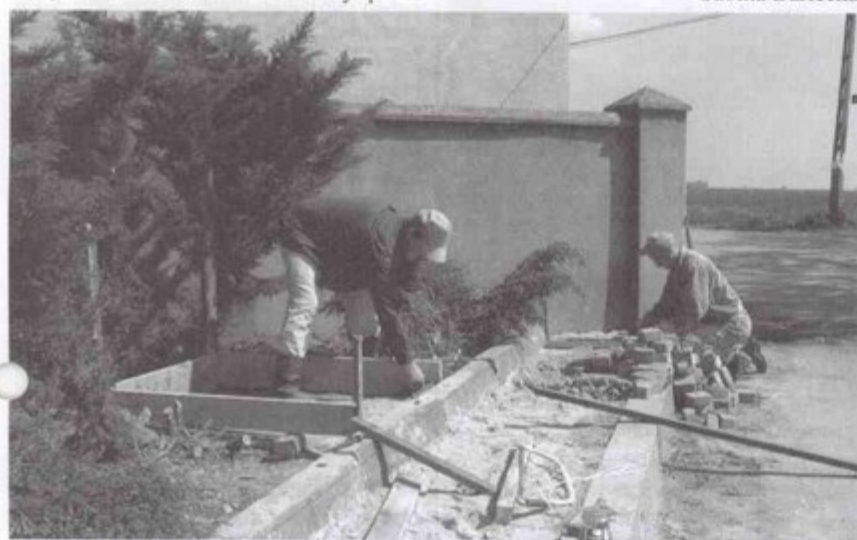
Trwają prace przy budowie pomnika z pamiątkową tablicą.
