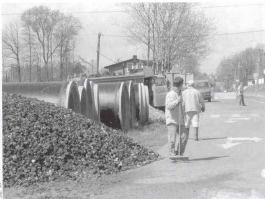
W pierwszym etapie robót zostanie zarurowany ciek Pawłówka.
