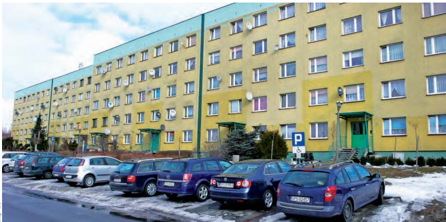
Mieszkańcy ulicy Górniczej 1 już niedługo nie będą mieli problemów z zaparkowaniem swoich samochodów. Za blokiem powstanie duży parking.
