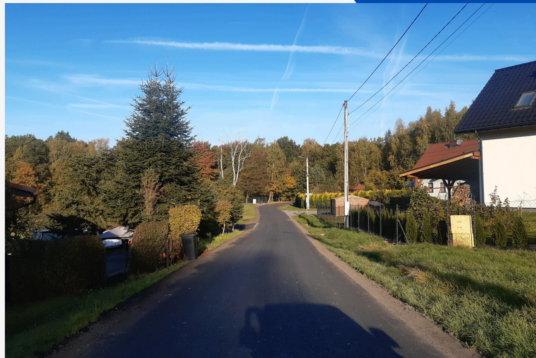
Remont wielkopowierzchniowy ul. Borowa (375 mb )
