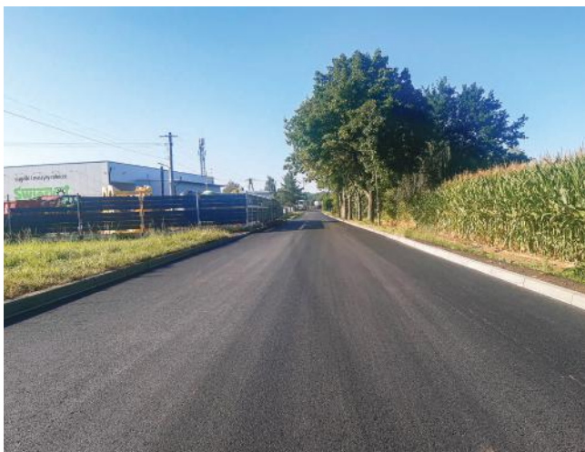
Ulica Grzybowa w Pawłowicach po remoncie
