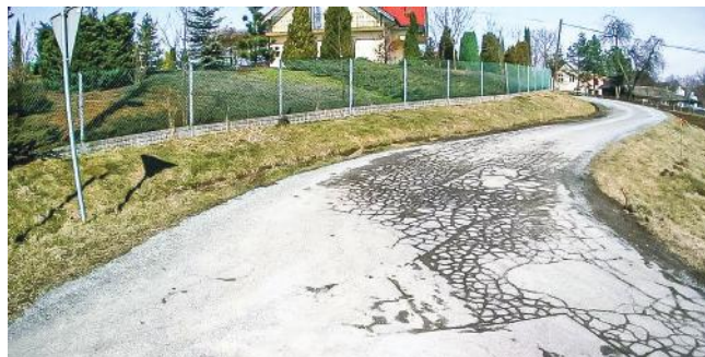
Ul. Jasna przed przebudową...
