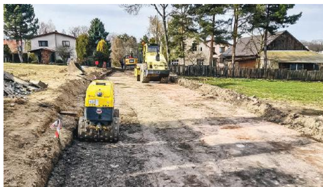
...i w trakcie prac
