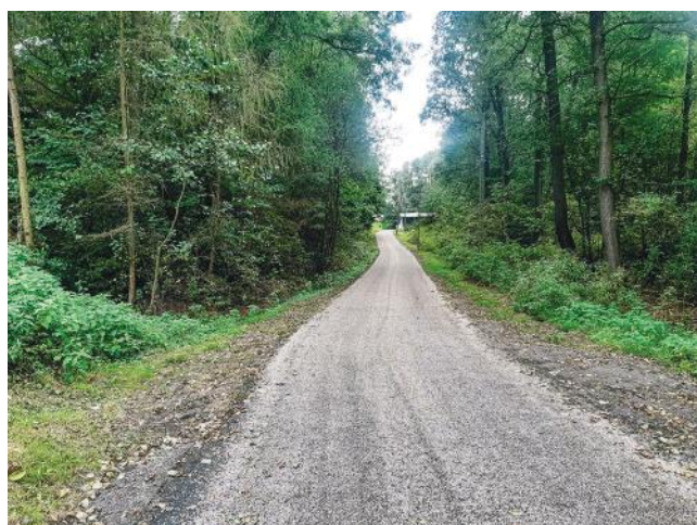
Na Akacjowej w Pielgrzymowicach utwardzono nawierzchnię grysami i emulsją.
